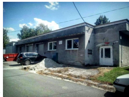
Pohľad na budovu hasičskej zbrojnice pred rekonštrukciou.
