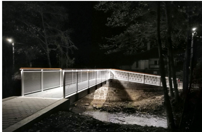
Pohľad na novú bezbariérovú lávku s osvetlením a napojením na miestnu komunikáciu novovybudovaným chodníkom.
