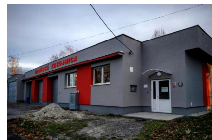
Budova hasičskej zbrojnice po rekonštrukcii a po označení názvom a logami.
