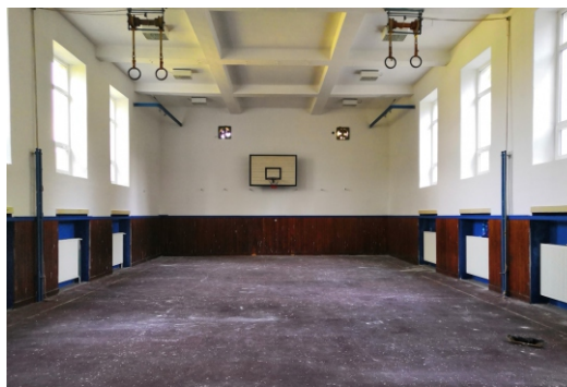
Telocvičňa ZŠ pred obnovou v júli 2019.
