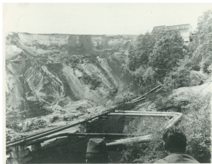
Pohľad na pretrhnutú hrádzu, čo spôsobili dlhotrvajúce dažde a priesaky vody na hrádzi. Dnes je lokalita známa ako Havarované zložisko.
