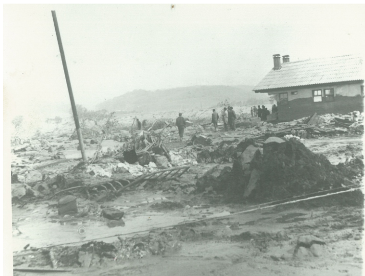
Stav v popolom zaplavenej časti obce po opadnutí prívalovej vlny. Na zvyšnom múre domu je viditeľné, akú výšku hladinu dosahovala prívalová vlna s popolom.
