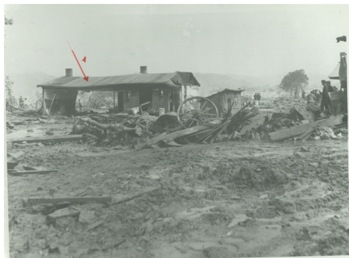
Torzo obytného domu poškodeného ničivou prívalovou vlnou. Zmes popola, vody a vápna strhla náprotivné obvodové múry domu a valila sa ďalej do dediny.
