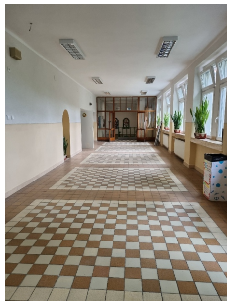
Chodba pred triedami po obnove.
