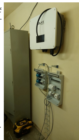
Elektrický rozvádzač a menič fotovoltaickej elektrárne v budove domu kultúry.
