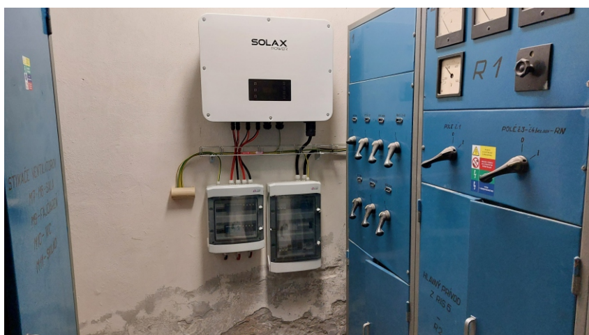
Elektrický rozvádzač a menič fotovoltaickej elektrárne v budove domu kultúry.
