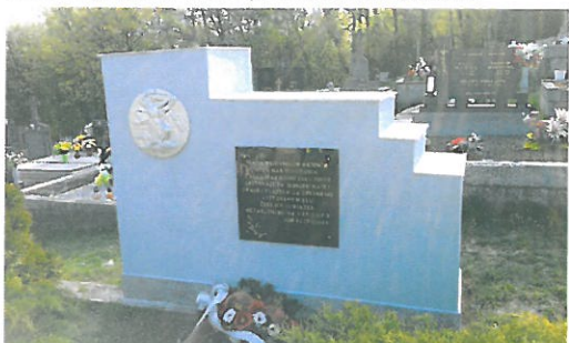
...a po rekonštrukcii.
