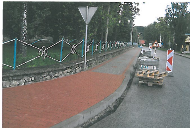
Rekonštrukcia chodníka na ulici L. Štúra. Zrekonštruovaných bolo takmer 400 metrov chodníka.
