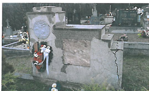
Pomník padlým v SNP pred rekonštrukciou...
