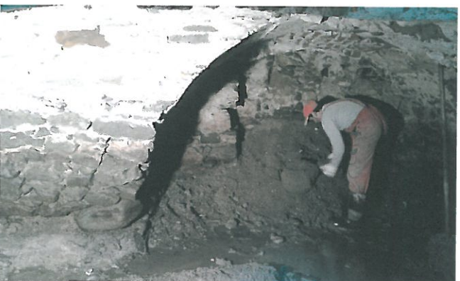
Čistenie pivnice pod barokovou kúriou. Značne zanesené priestory rôznym stavebným odpadom a hlinou zapričiňovali vlnutie celej stavby kúrie.
