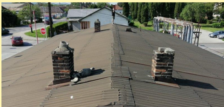
Strecha združeného objektu č. 3 pred výmenou strešnej krytiny.
