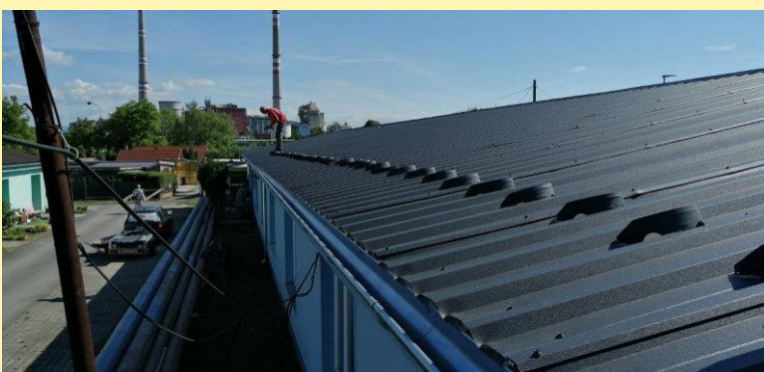
Strecha združeného objektu č. 3 v čase ukončovania prác po výmene strešnej krytiny.
