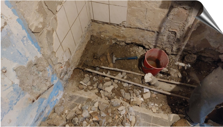
Oprava rozvodov vody v združenom objekte č. 3, kde sídli drogeria, klub dôchodcov, dielne a šatne zamestnancov a dva nájomné byty
