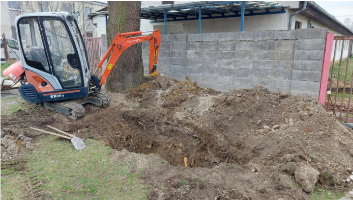
Oprava prípojky vody pred areálom budúceho zberného dvora
