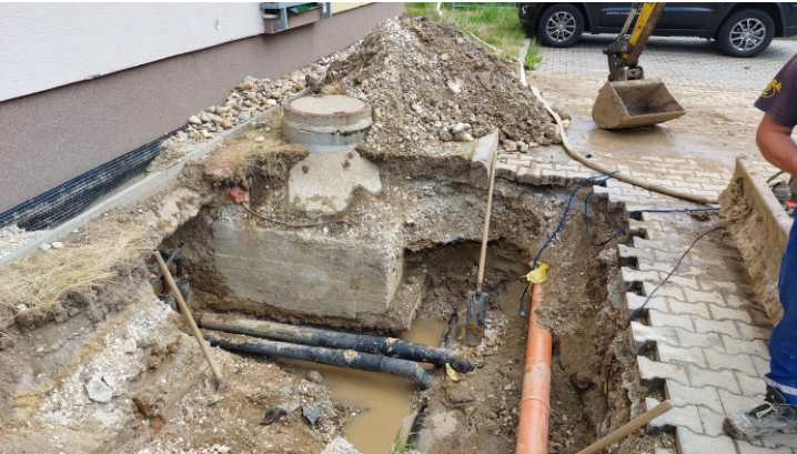
Oprava teplovodnej prípojky pre nájomný bytový dom č. 683.
