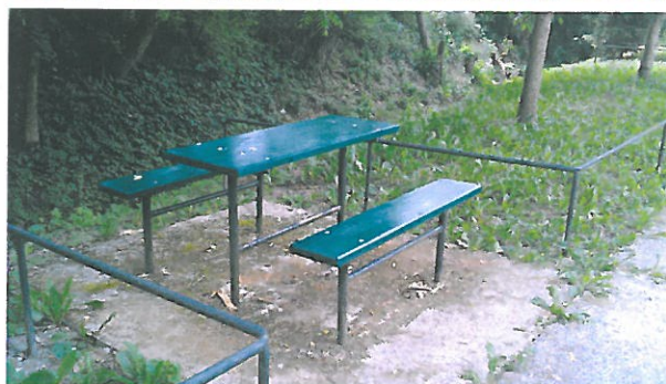
Oprava lavičiek pri cintoríne Hôrka. Pohľad pred opravou a po oprave.
