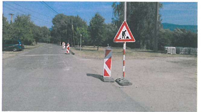
Počiatkové práce rekonštrukcie miestnej komunikácie na ulici Boženy Nemcovej.
